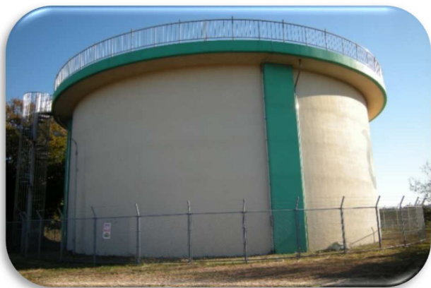
第1(粕屋南)配水池
