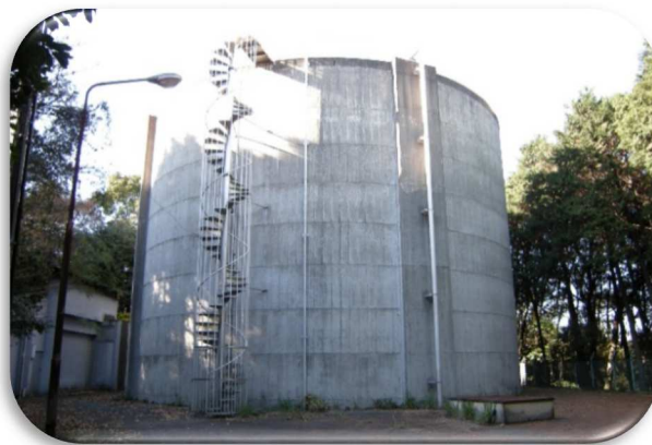
第2(西尾山)配水池
