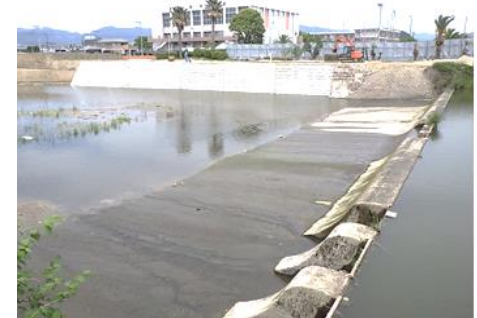
固定堰から自動転倒堰へ
