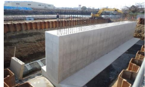
多々良川に架かる橋を工事中
