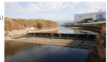
改修予定の有崎堰
