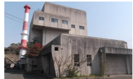
粕屋町清掃センター(旧焼却場)
