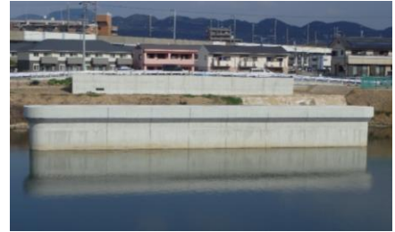
多々良川に架かる橋を工事中
