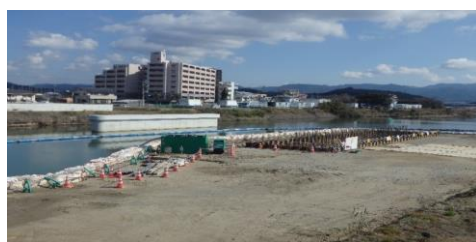
多々良川に架かる橋を工事中
