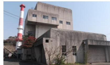
粕屋町清掃センター(旧焼却場)
