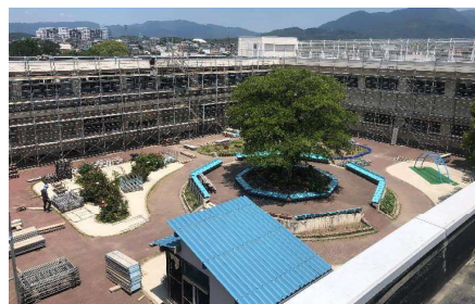
仲原小第1期大規模改造工事
