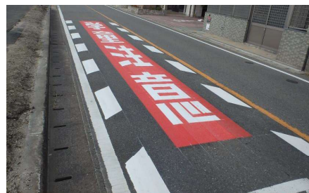
危険箇所への路面標示
