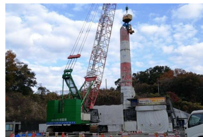
粕屋町清掃センター解体工事
