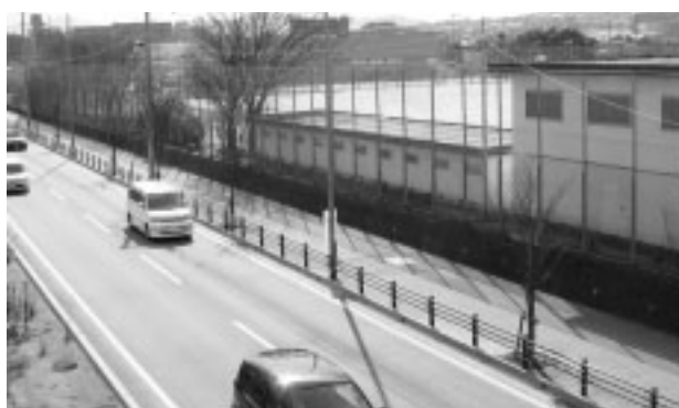
粕屋中学校グラウンドフェンス
