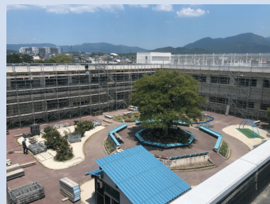
仲原小第一期大規模改造工事
