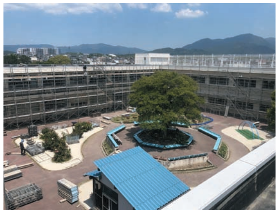
仲原小第一期大規模改造工事
