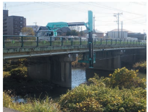
橋梁保守工事
