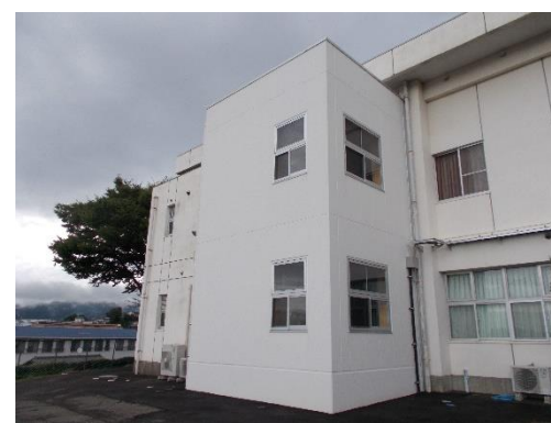
上大隈公民会館エレベーター設置工事
