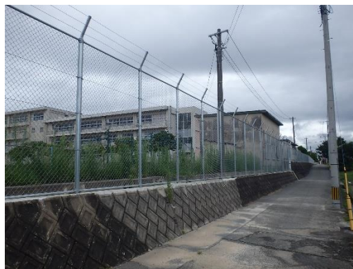
粕屋東中学校ブロック塀改修工事
