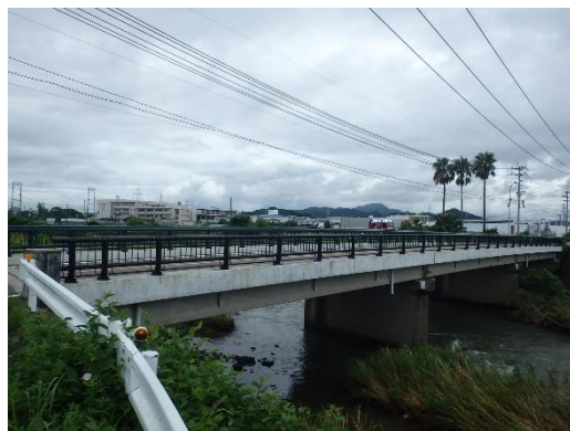
江辻橋橋梁補修工事
