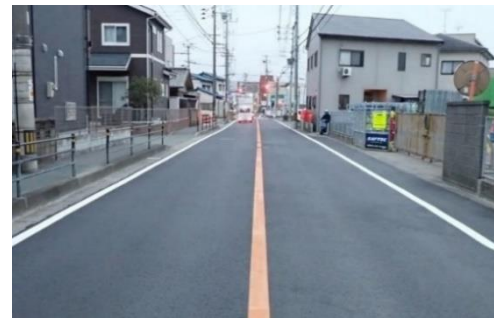
広田・二股瀬線道路舗装工事
