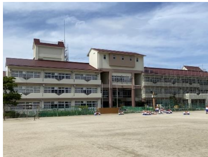
粕屋中央小学校大規模改造工事
