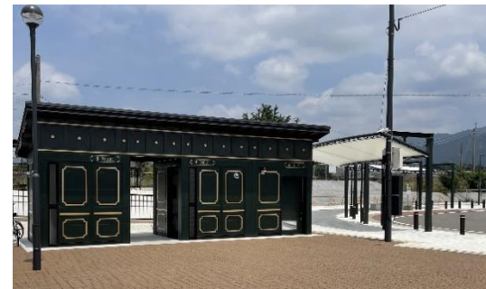
酒殿駅前整備工事
