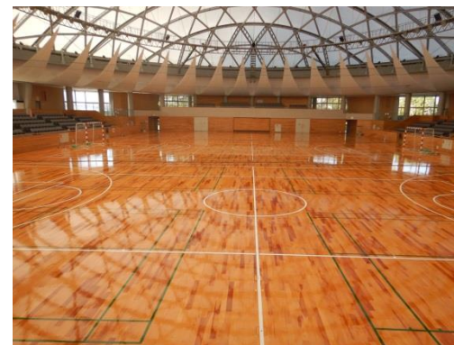
かすやドーム床改修工事
