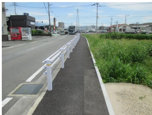
土井の内・砂子田線歩道設置工事
