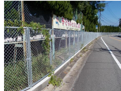
大川小ブロック塀改修工事
