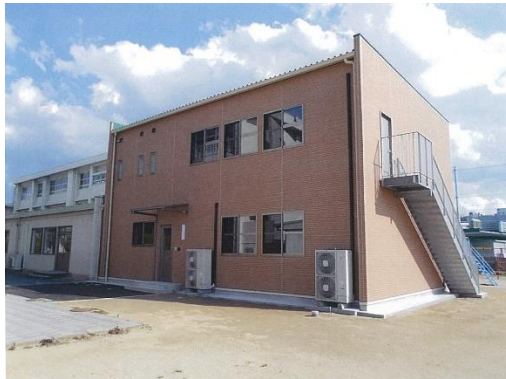
粕屋西小放課後児童クラブ室増築工事
