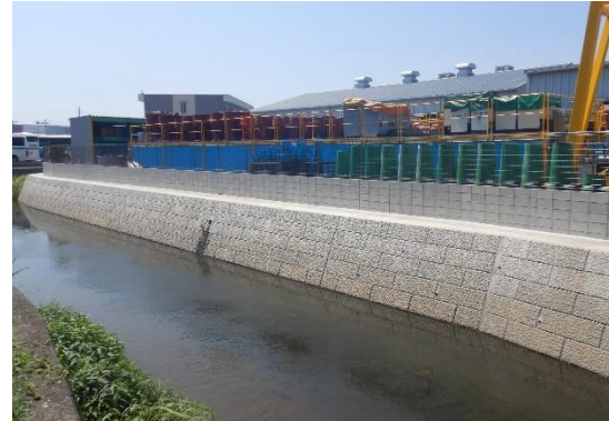
南里水路護岸改修工事
