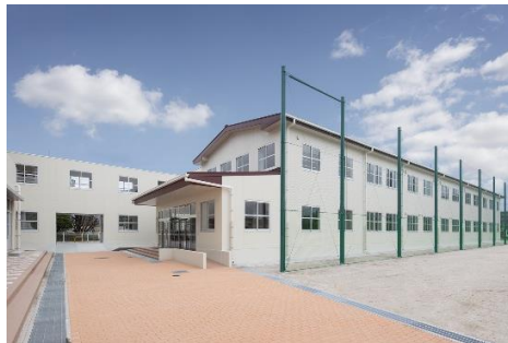
粕屋中央小学校増築工事
