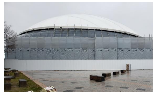
粕屋町総合体育館大規模改造工事
