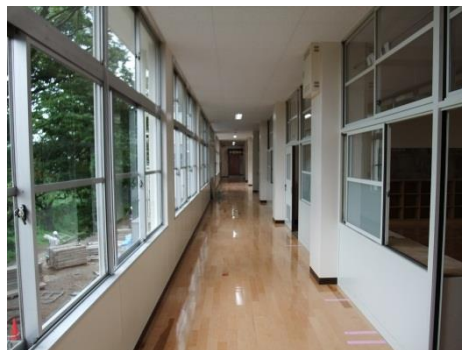
大川小学校改修工事
