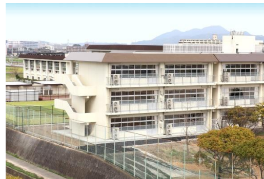
粕屋中学校増築工事
