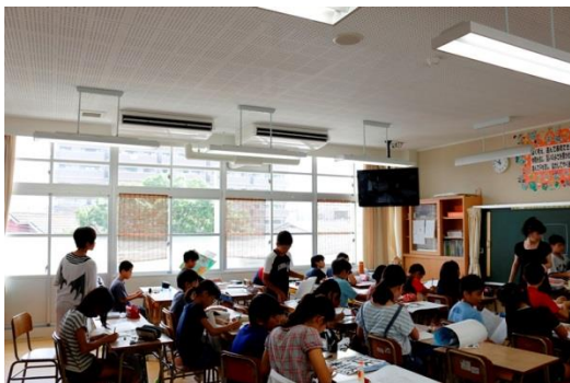
小中学校空調設備設置工事
