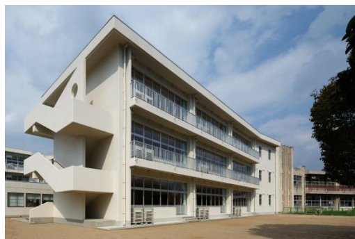
粕屋西小学校増築工事
