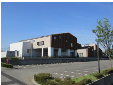
こども館建設工事
