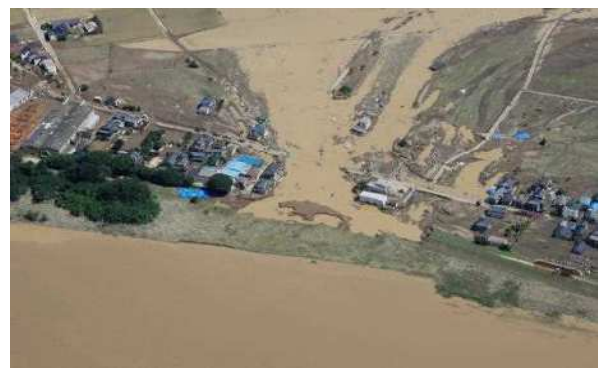
堤防決壊による家屋の流失(鬼怒川)
