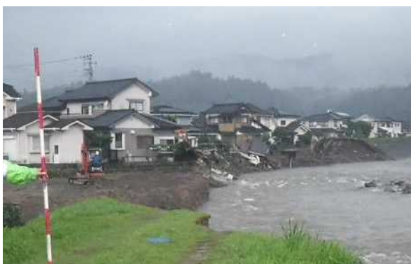
河岸侵食による家屋の倒壊(花月川)
