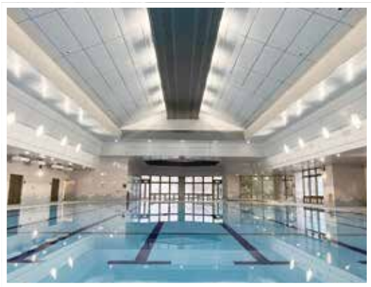
かすやドームプール棟の大規模改造工事を行いました。
