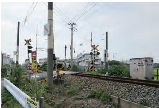
K. <鉄道>踏切保安装置/軌道/電柱/防護柵/設備箱 令和2年(2020)7月8日撮影
