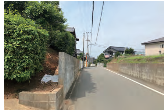
J. <道路>防護柵/カーブミラー/側溝/電柱 令和2年(2020)7月8日撮影
