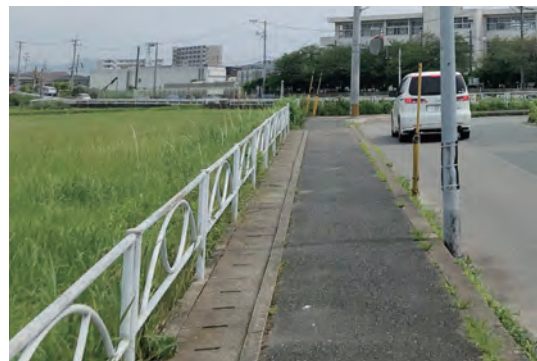
D. <道路>防護柵/側溝 令和2年(2020)9月10日撮影
