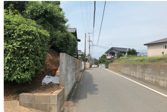
J. <道路>防護柵/カーブミラー/側溝/電柱 令和2年(2020)7月8日撮影
