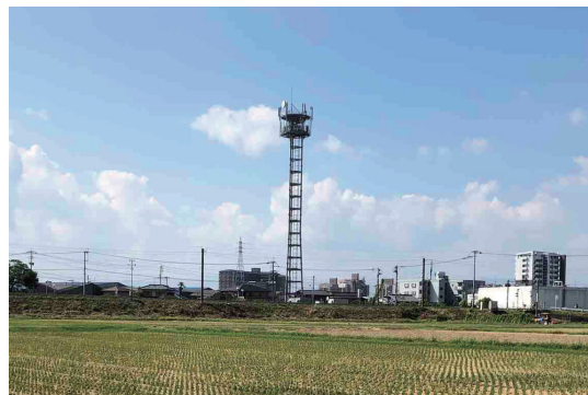
L. <鉄道>鉄塔 令和2年(2020)9月10日撮影
