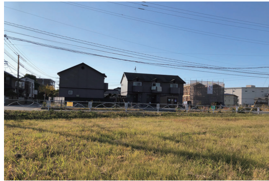
N. <住宅地>建物 令和2年(2020)11月13日撮影
