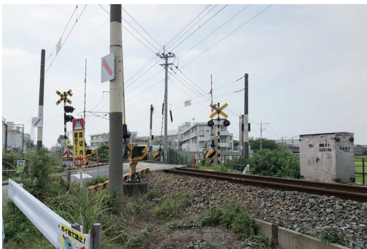
K. <鉄道>踏切保安装置/軌道/電柱/防護柵/設備箱 令和2年(2020)7月8日撮影
