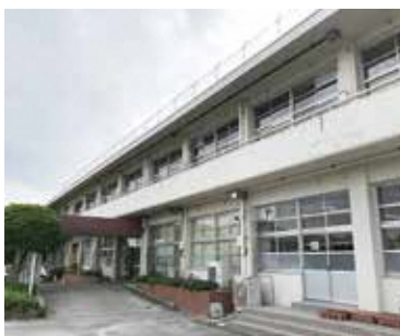
改造工事前の仲原小学校
