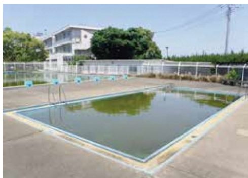
西小学校プール
