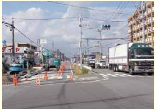
拡幅中の千代～粕屋線
