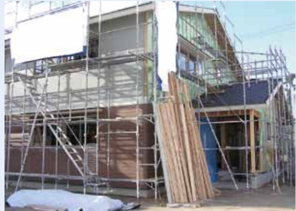
建設中の中央小学校 学童保育所
