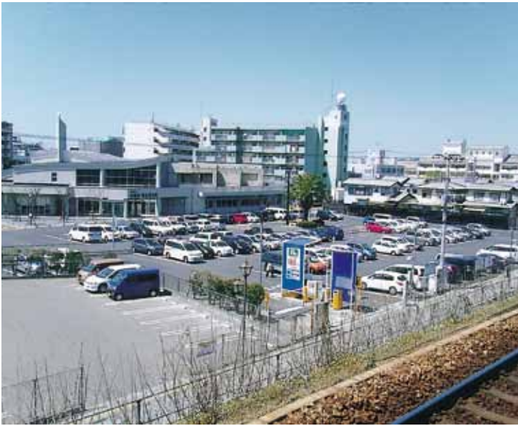
かすやフォーラム調整池工事予定地
